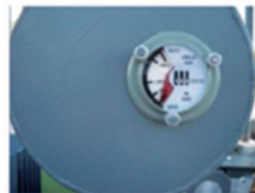
Figura 4.5: Verifica del livello dell'olio
