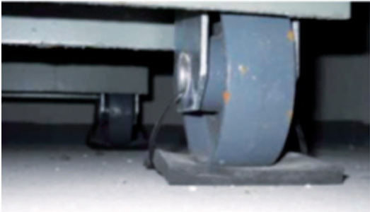
Figura 4.13: Posizionamento gomma anti-vibrazioni
