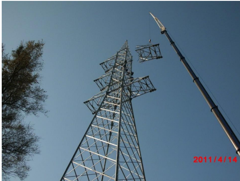
Montaggio mensole con autogru
