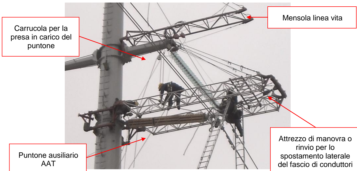
Figura 19: Esempio di puntone ausiliario AAT
