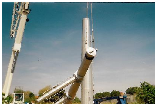
Figura 15: Imbracatura per sollevamento con briglia
