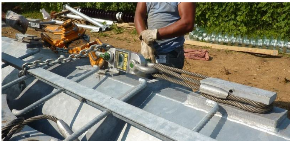
Figura 14: Paranco con cella di carico
