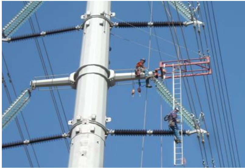
Figura 17: Esempio di mensola ausiliaria AAT
