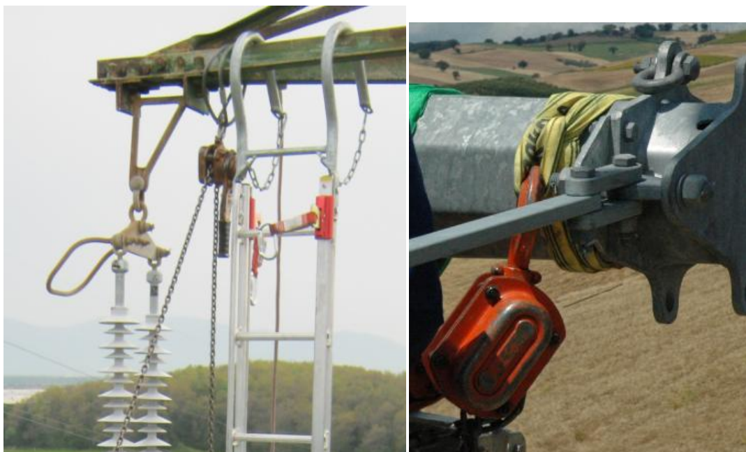
Figura 5: Punti di fissaggio dell'attrezzatura di manovra con briglia metallica (sinistra) o in fibra (destra)
