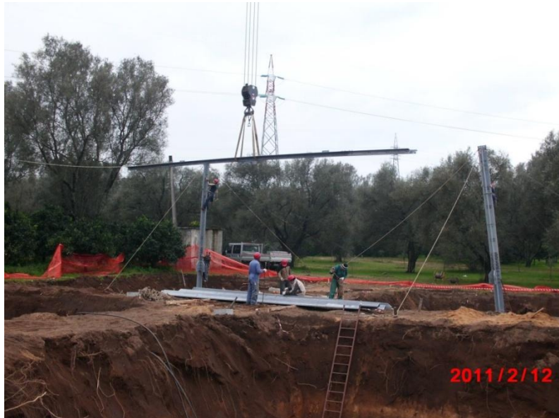
Montaggio basi con autogrù ad aste sciolte
