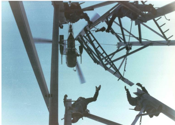
Montaggio sostegni a tronchi con elicottero
