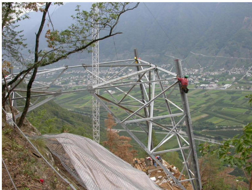
Montaggio basi con falcone ad aste sciolte
