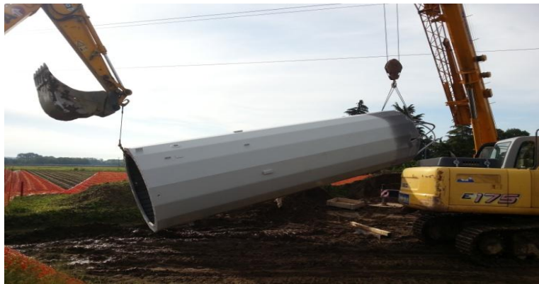
Figura 5: Movimentazione tronco di base
