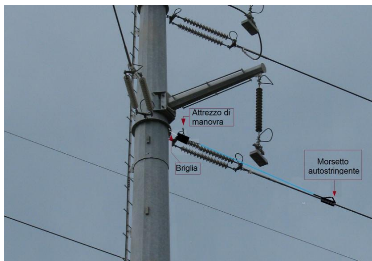
Figura 13: Disegno schematico di presa in carico diretta del conduttore su amarro su fusto del sostegno
