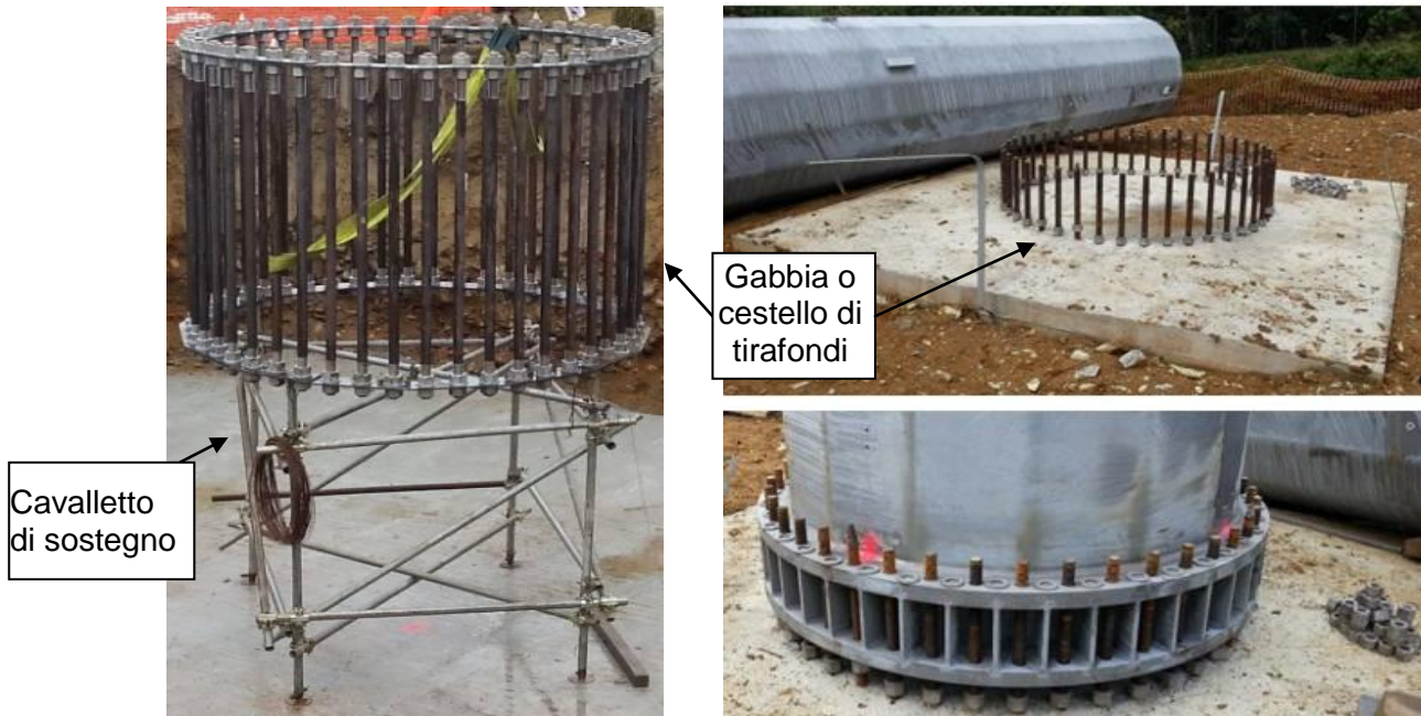
Figura 1: Gabbia di tirafondi su cavalletto di sostegno e posta nel blocco di fondazione
