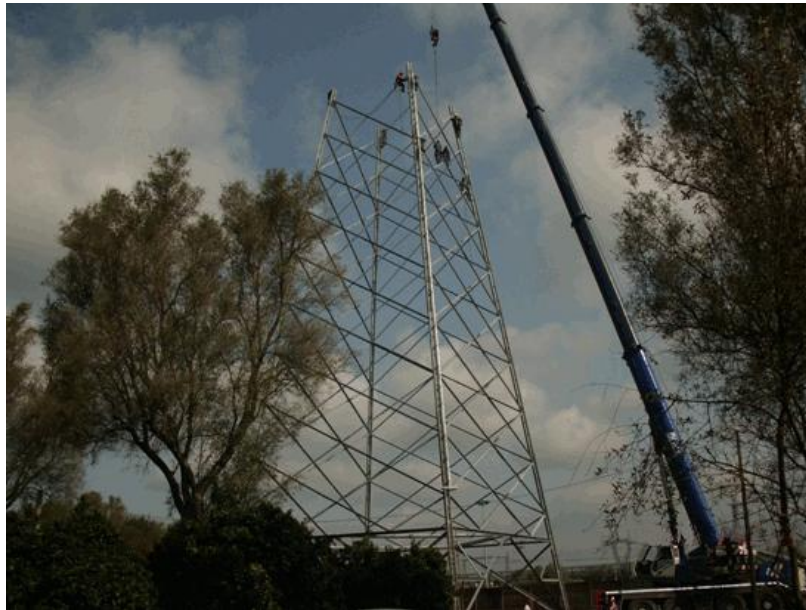
Montaggio sostegni ad aste sciolte con autogrù
