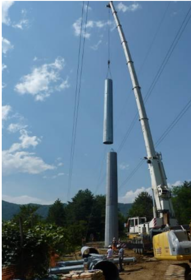
Figura 11: Foto indicativa montaggio tronchi intermedi con autogru
