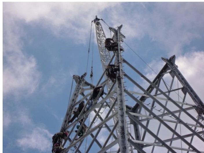
Montaggio sostegni ad aste sciolte con falco
