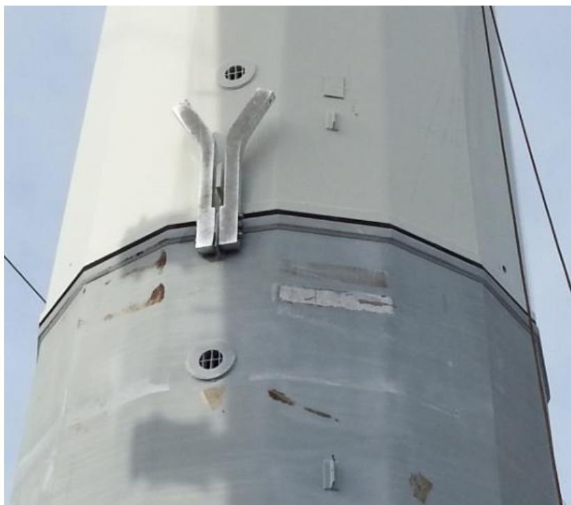
Figura 10: Forca di centraggio fra tronchi
