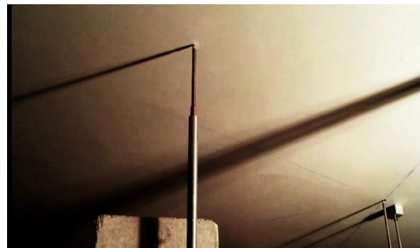
4. Particolare intradosso, zona centrale
